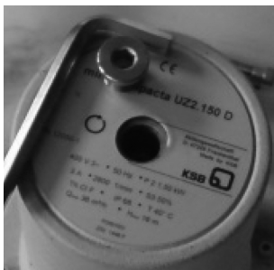
Obr. 14: Směr otáčení čerpadla
